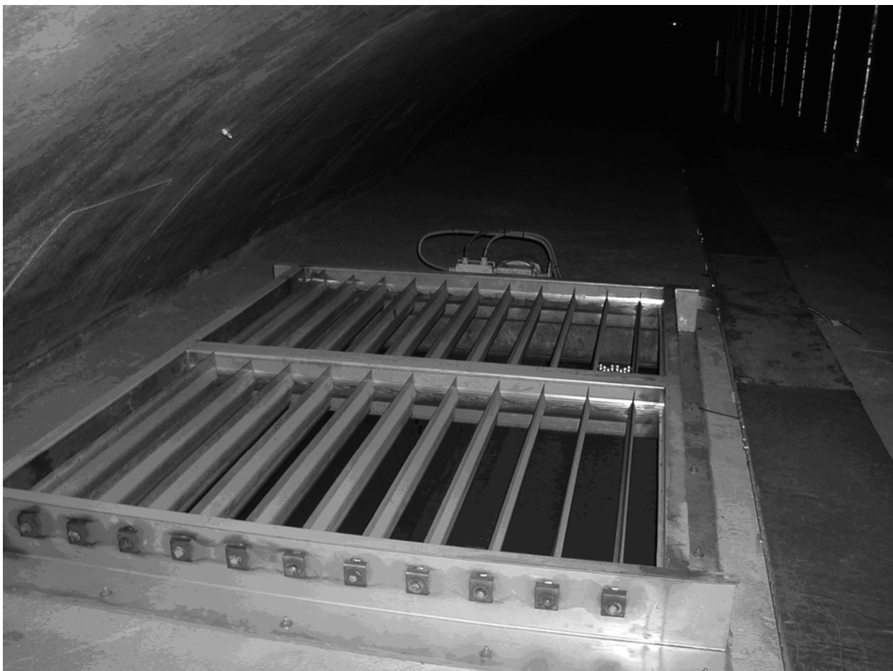
Figure 12.4.5 - Installation d'une trappe d'extraction à lames parallèles / Parallel bladed smoke damper installation
